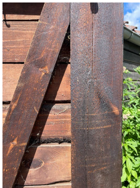
Fig. 6. Skur indvendigt behandlet med en halvtransparent brun pigmenteret overfladebehandling, der har en vis lighed til en ældre form for traditionel tjærebehandling. Der kan være tale om et af tidens kommercielle og meget udbredte pigmenterede såkaldte trækonserveringsbehandlinger Solignum, der også blev anvendt præventivt som et middel mod svamp. Det brune pigment er formentlig brændt umbra.
