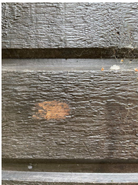
Fig. 5. Afdækning på skur Granholmen 26 ned til den oprindelige halvtransparente brun pigmenterede træbeskyttelse.
