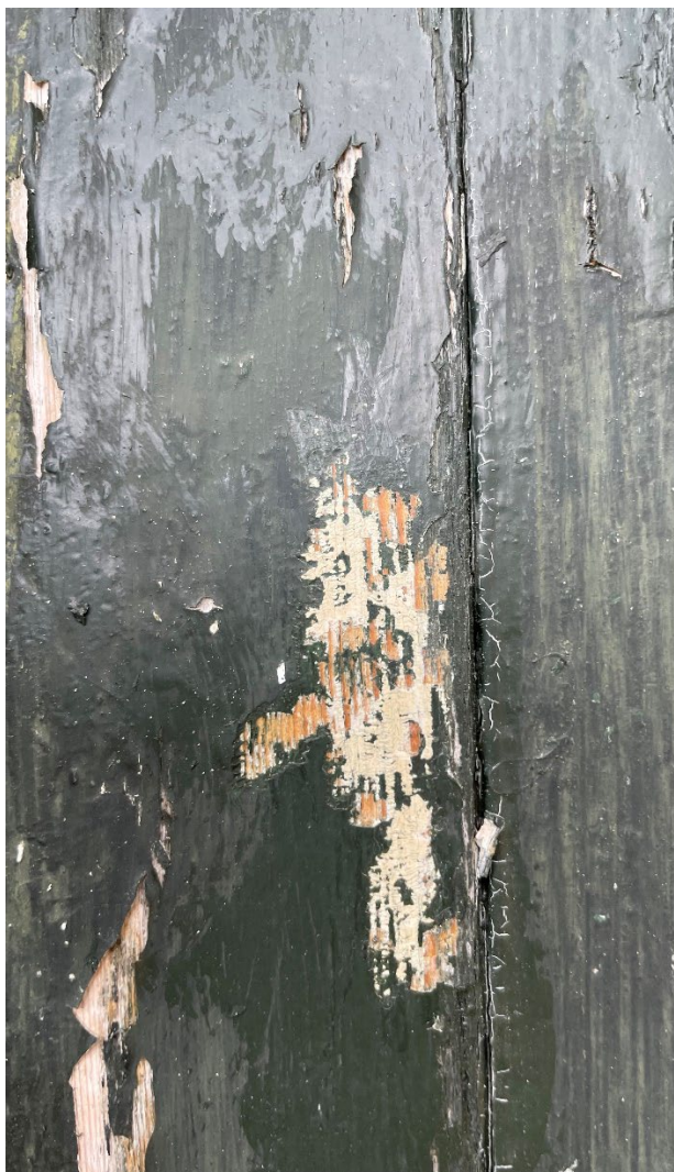
Fig 12. Afdækning på køkkenvindue Parcelvej 28A. Som hoveddørsskodden og hoveddøren var køkkenvinduet oprindeligt malet hvidt og ikke grønt.
