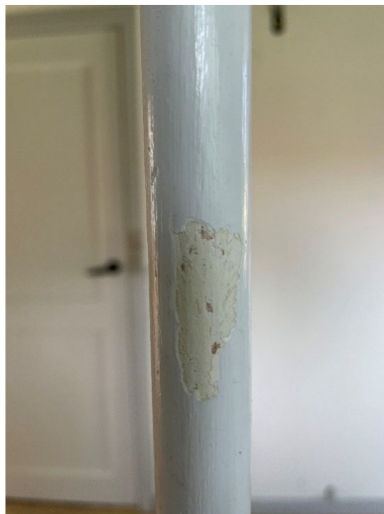
Fig. 20. Afdækning af det oprindelige malingslag på baluster, trapperum Granholmen 26.
