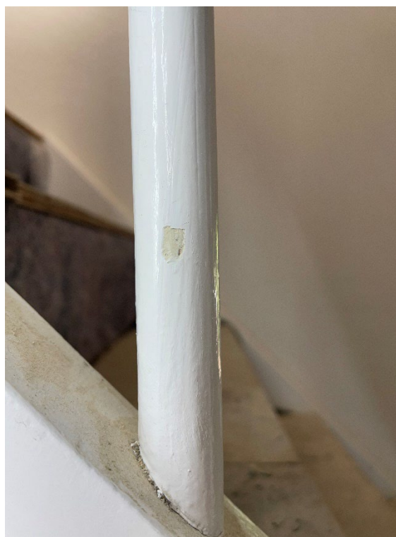
Fig. 22. Afdækning på baluster i trapperum Parcelvej 28A.
