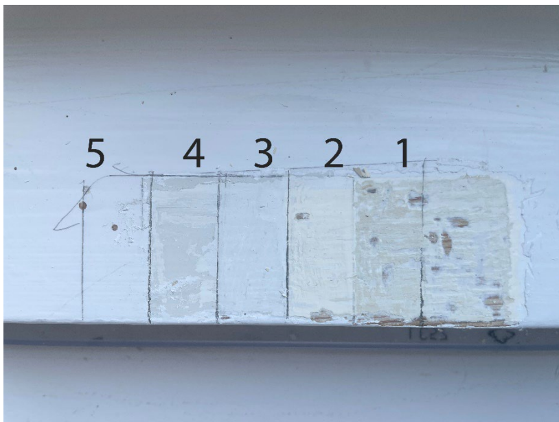
Fig. 23. Lagvis afdekning på vindueskarm i trapperum Granholmen 26.
