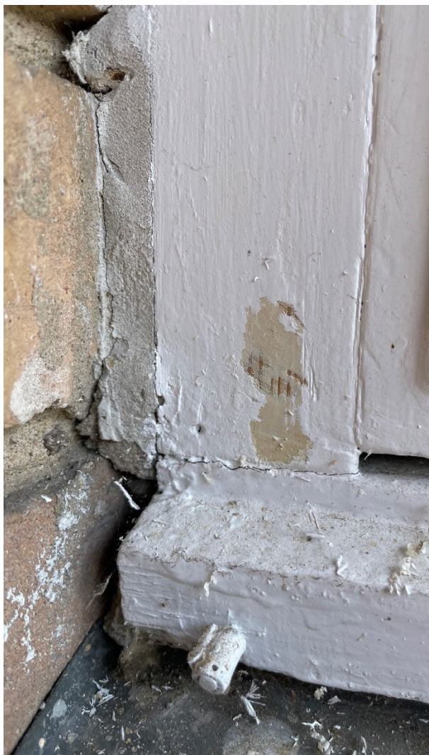
Fig. 13. Afdækning af oprindelig varm tonet hvid bemaling på stuevindue Granholmen 26.
