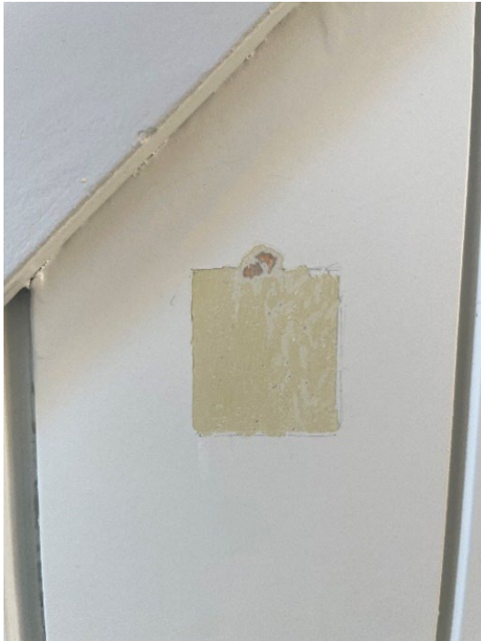
Fig. 30. Træbeklædning under trappeløb i trapperum
