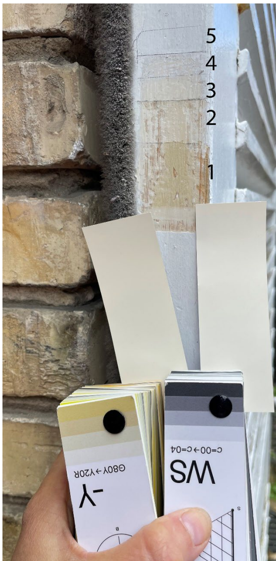
Fig. 10. Oprindelig farvesætning af det hvidmalede træværk. Her lagvis afdekning på dørskodde ved hoveddør Granholmen 26. Slutstrygningen en hvid maling tonet med lidt okker og sort pigment. Farven er tydeligt mørknet og gulnet. Derfor tolkes den oprindelige hvide farve som en mellemtning af de her viste NCS-farver. På dette tidspunkt blandede man til vinduesmaling typisk flere hvide pigmenter sammen, for at udnytte og kombinere pigmenternes forskellige egenskaber. Den oprindelige tonede hvide farve består derfor sandsynligvis af blyhvidt, zinkhvidt og titanhvidt i et ukendt blandingsforhold. Den hvide farveblanding er tonet med lidt okker og sort pigment.
