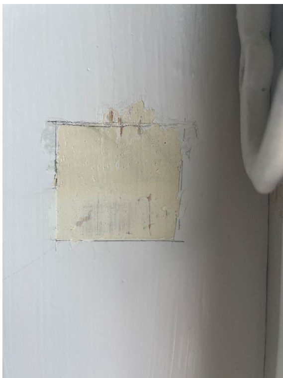
Fig. 21. Afdækning af oprindelige bemaling på vindueskarmtræ i trapperum Granholmen 26.
