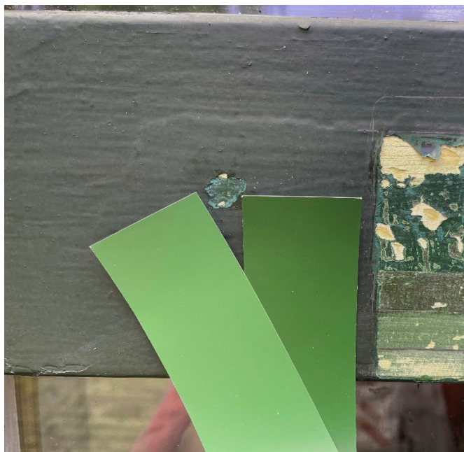
Fig. 16. Lagvis afdækning på bryggersdør Granholmen 26 af de ældste malingslag. Vær opmærksom på, at der sker en markant farveforvanskning i den fotografiske farvegengivelse af NCS farvekortene. Den grønne farve på NCS-kortet er mindre gul og mere farvemættet i virkeligheden. Alt peger på, at den oprindelige grønne farve er en kromoxidgrøn.
