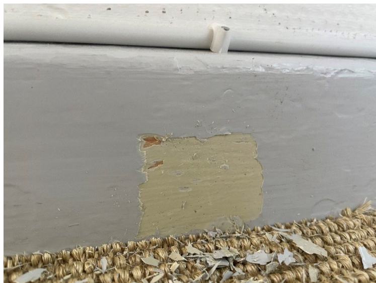
Fig. 27. Fodpanel i trapperum Granholmen 26. Det er her tydeligt, at den første malerbehandling er afsluttet med en såkaldt lakfarve. Til slutstrygningen af træværk i interiører tilsatte man ofte ca. 20 % lak. Der kan være tale om den billige kolofoniumharpiks, der på dette tidspunkt kunne købes i en kemisk behandlet udgave, der mindskede den naturligt kraftige gulning af farven. Eller det kan være en tidlig udgave af en alkydmaling. Som det er tydeligt her gulnede malingen fortsat uanset tilsat laktype.
