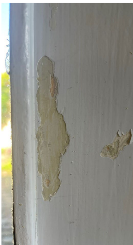
Fig. 28. Hoveddør i interiør, Granholmen 26, malet med samme lysegrå som meget andet træværk.
